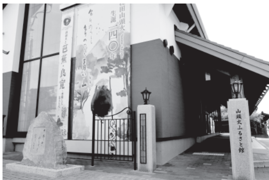
▲9月4日に完成したアプローチ装飾(門柱)
